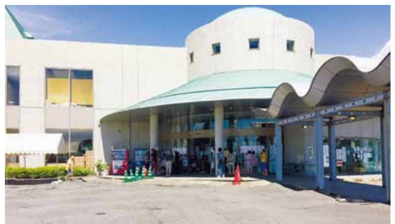
避難所になっている益城町総合体育館。前面の駐車場は波打っていた
